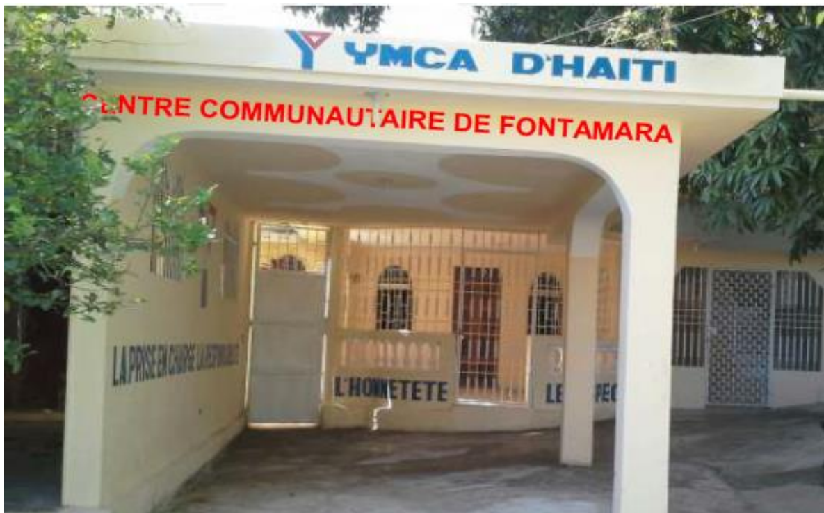
Le nouveau point de service de YMCA d'Haïti implanté cette année à Fontamara. (Crédit : YMCA)
